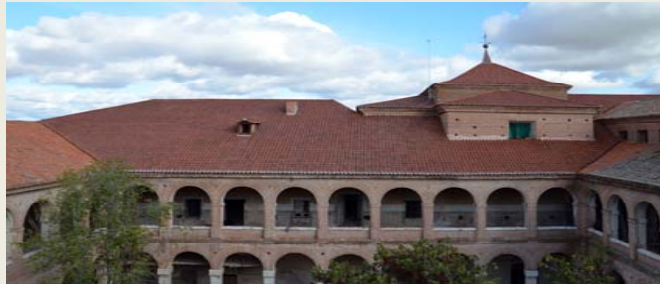
Vista general de cubiertas tras la intervención.
