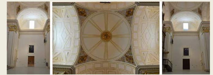
Bóvedas. Crujero de la iglesia.
