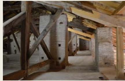
Restauración de estructuras con prótesis.
