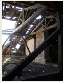
Cubiertas, estado inicial.
